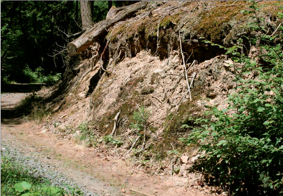
Wegeböschung mit Bodenanschnitt Foto: Thomas Müllen
